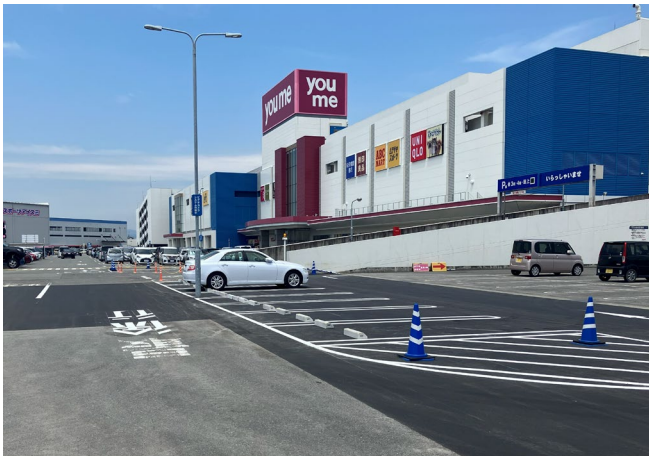
ハリロードを使用したゆめタウン徳島の駐車場舗装（一部）
