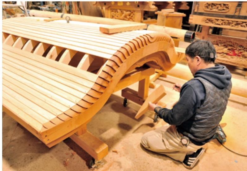
写真中央、作業場の全景。本体を解体して、部材の歪みや反りを直し、仕口・継手を調整し、再度組み直す。写真右下は、屋根板を葺き直しているところ。
