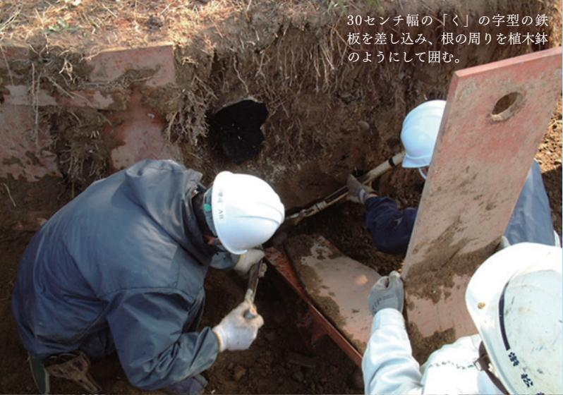
30センチ幅の「く」の字型の鉄板を差し込み、根の周りを植木鉢のようにして囲む。
