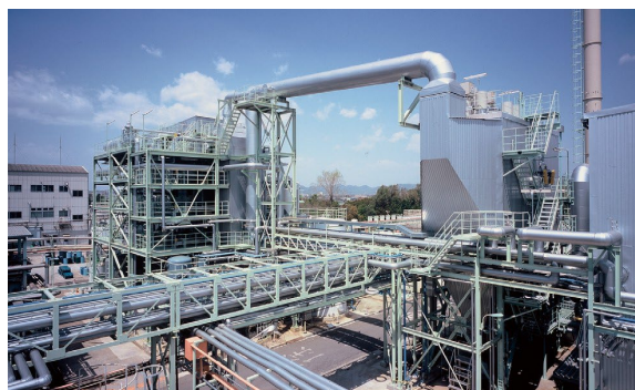
▲バイオマス発電設備
