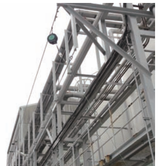
▲ローリー荷下り場の安全帯と煎り付けケーブルおよび安全ブロッコ設置
