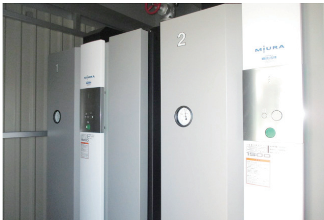
▲更新した仙台工場のLPガス蒸気ボイラー
