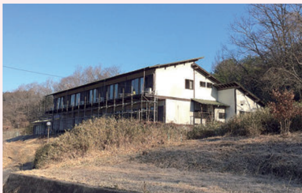
▲4月から引きこもりの若者を受け入れるシェアハウス(改装工事当時の写真)
