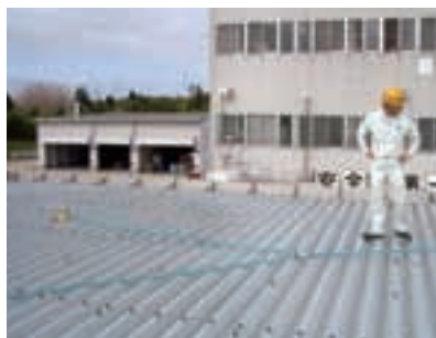
事務所屋上に散水用スプリンクラーを設置、冷房効率を向上させ省エネに取り組みました。(茨城工場)
