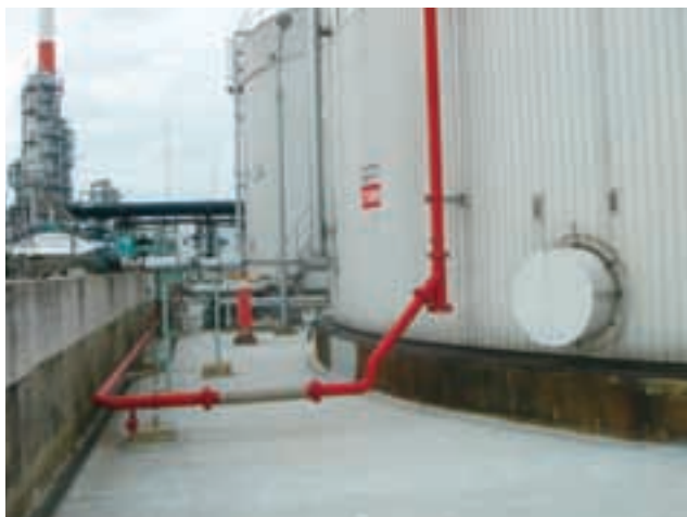
防油堤内のコンクリート化の実施
