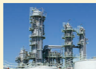
現在のトール油精留プラント
